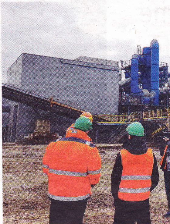
En bleu, la cheminée du broyeur, à gauche en gris, le nouveau bâtiment abritant les panneaux ultrafiltrants.
